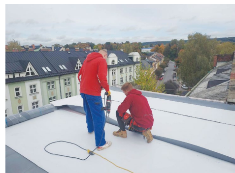
Oprava střechy ZŠ Habrmanova
