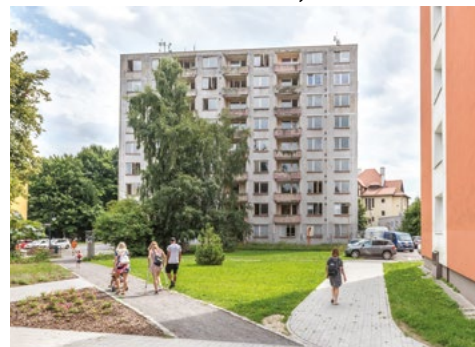
Začala rekonstrukce bytového domu na Novém náměstí Rezidence Rozmarýn / foto: Michal Horák
