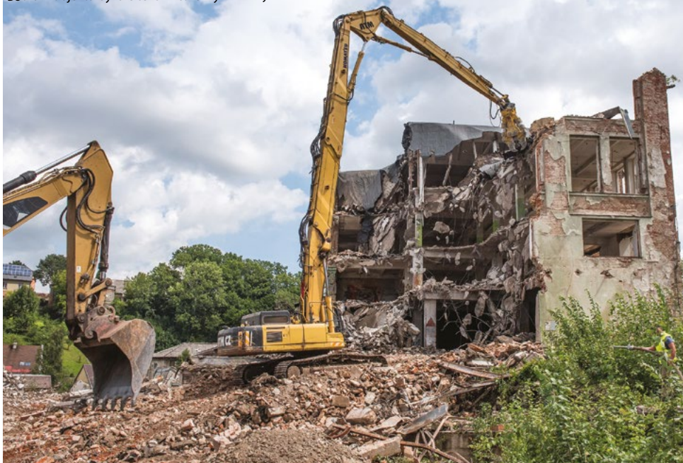
Bourání objektu bývalé textilní továrny Primony na konci července 2021 / foto: Michal Horák
