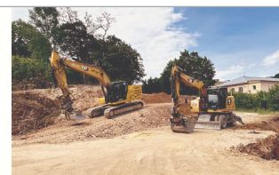
Stavební práce v lokalitě Na Primoně
